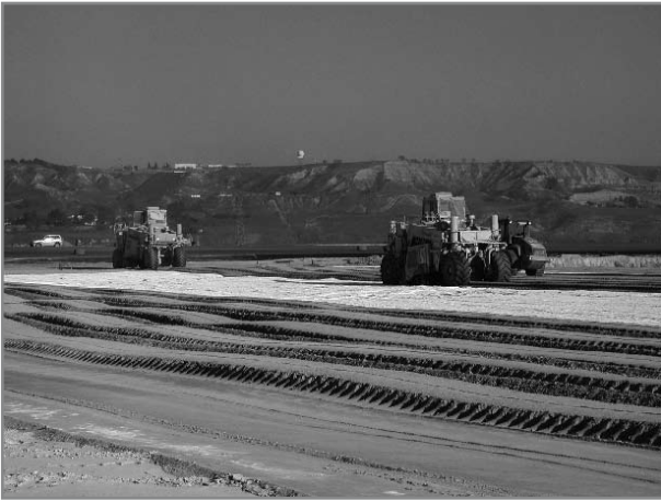
Foto 5. Estabilización de suelos.
