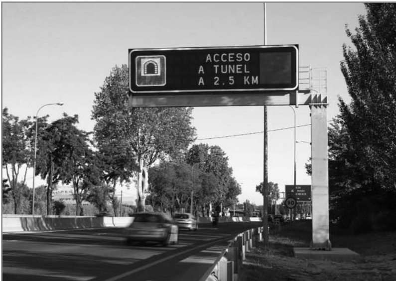
Foto 2. Información al usuario a través de paneles de mensaje variable. (Fuente: Postigo, obras y servicios).
