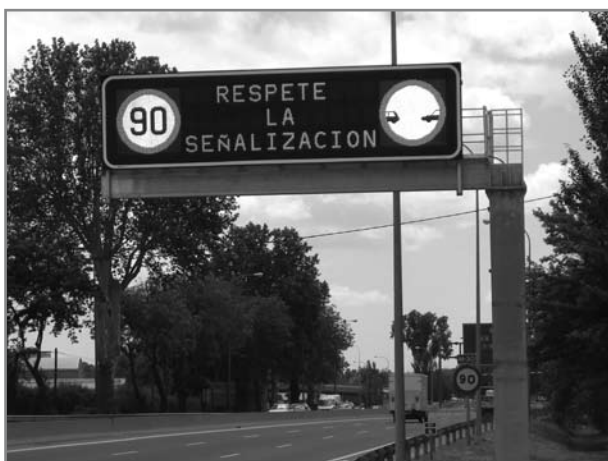
Foto 1. PMV compuesto por 2 zonas gráficas, con resolución de 64 x 64 píxeles y 3 líneas alfanuméricas de 12 caracteres de 320 mm de altura.
