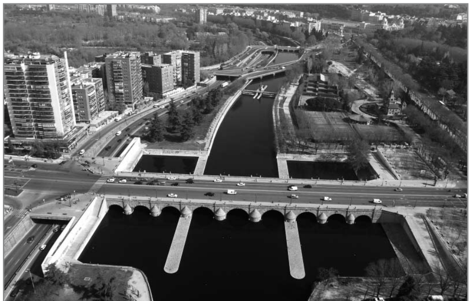
Foto 1. Vista aérea del estado anterior de la M-30, a su paso por el Puente de Segovia (Madrid).
