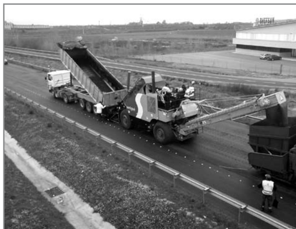
Foto 7. Puesta en obra de mezclas bituminosas.
